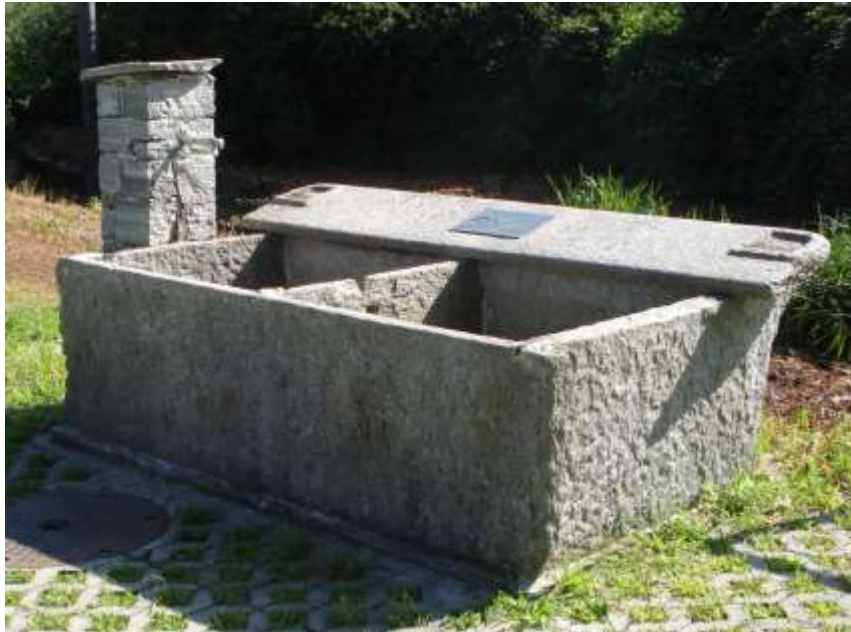
La bella fontana in Via dei Borghesi sul Piano in territorio di Locarno
