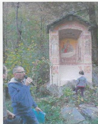
Capela da Mezzagn Sott
