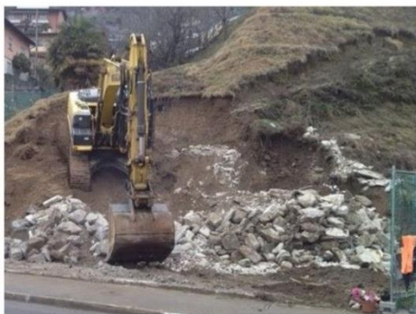
A GORDOLA si demolisce e basta
