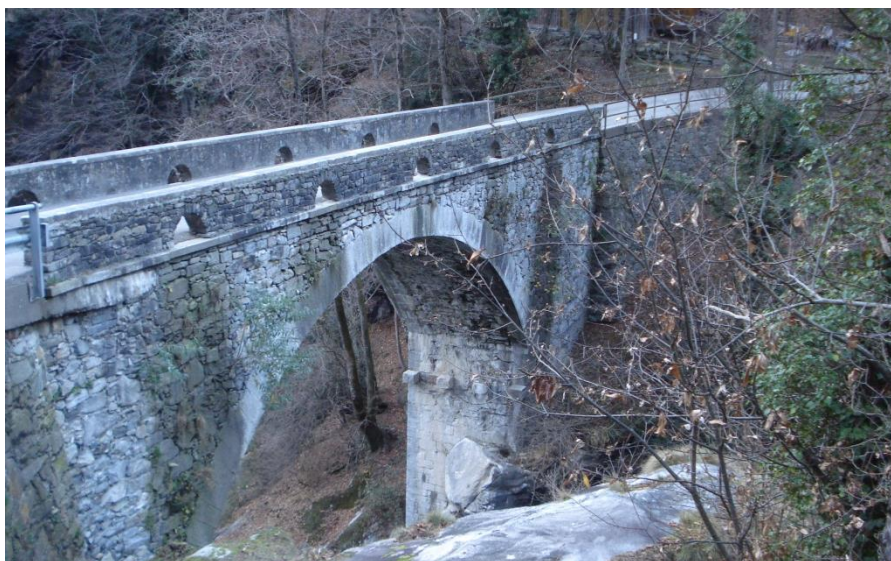
Il ponte sulla strada per Corippo
