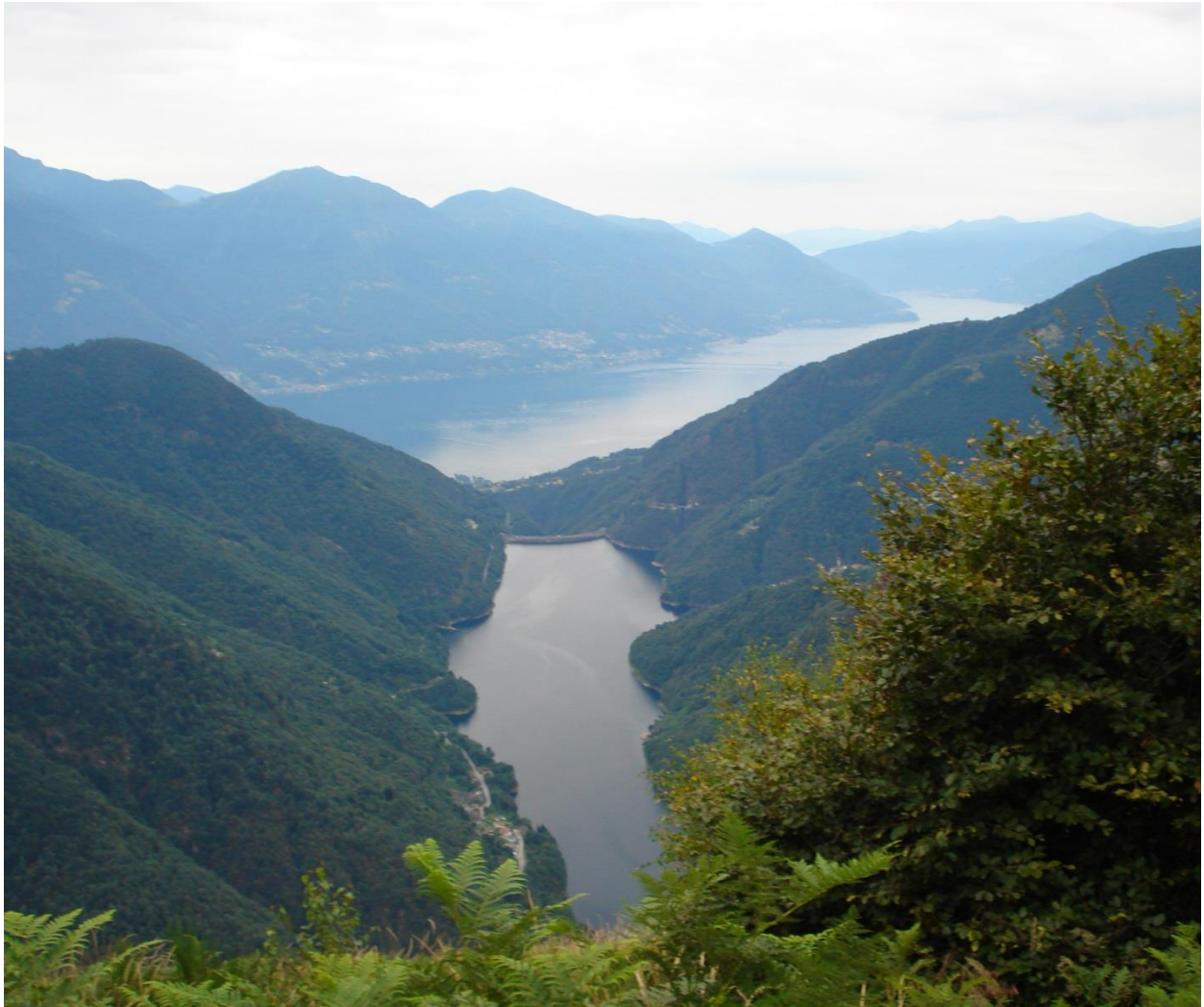
In primo piano il “Lago di Vogorno” con la “Diga di Contra” (Fotografia scattata salendo con la teleferica che porta a Bardughée)
